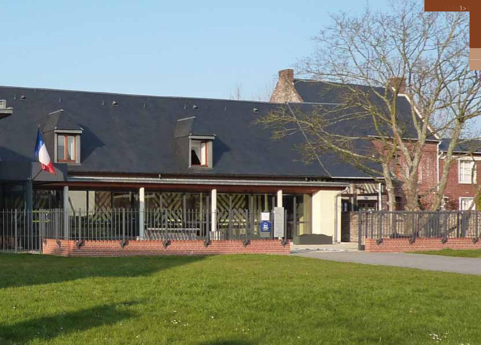
éclatante de soleil car extrêmement vitrée, l'autre, au Nord, plus à l'abri de la lumière. Réhabilitée en mettant en exergue ses qualités intrinsèques comme sa structure à pans de bois et torchis édifiée sur un muret de soubassement en maçonnerie composite, les trois salles de la construction accueillent les collections permanentes. Mises en scène par un scénographe, elles racontent l'his-
